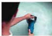
**1.** Preparación de superficie mediante los medios mecánicos necesarios en cada caso, tales como pulido mediante segmento metálico de diamante y posterior barrido y aspirado de los escombros generados.
