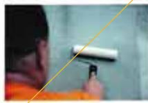
**5.** Aplicación de 1 capa de **BYOND PRIMER** mediante rodillo como tapa poros, con un rendimiento de 0,120Kg/m<sup>2</sup> y a continuación una vez seco, aplicación de 2 capas de **BYOND BARNIZ** con un consumo de 0,120kg/m<sup>2</sup> mediante rodillo de pelo corto.
