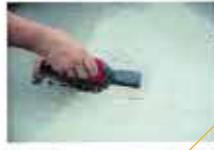
**4.** Aplicación de 2 capas de **MICRODUR FINO COLOR** con un consumo de 0,700Kg/m<sup>2</sup> mediante llana plástica para poco dibujo o llana metálica para acentuar el dibujo.
