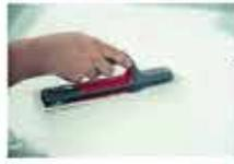
**3.** Aplicación de una segunda capa de **MICRODUR BASE COLOR** con un consumo de 0,600Kg/m<sup>2</sup> mediante llana plástica o metálica.
