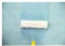
**2.** Aplicación de una primera de capa a modo de imprimación, **LATEX 200**, dejando una dotación aproximada de 0,15 Kg/m<sup>2</sup>, aplicada con rodillo + colocación de malla de 3x3 mm y de 60gr. A continuación 1 capa de **MICRODUR BASE** mediante llana metálica con un consumo de 1kg/m<sup>2</sup>
